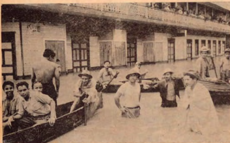
En los negocios comerciales las aguas subieron casi un metro, siendo por este motivo, grandes las pérdidas.
